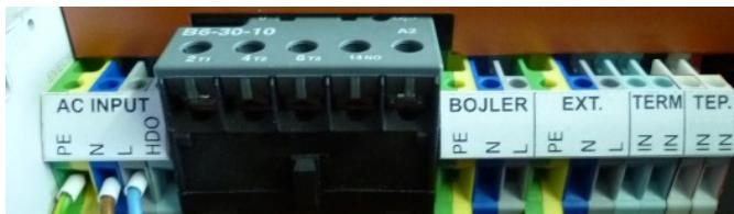
Nejprve zkontrolujte, zda máte odpojen elektrický přívod bojleru (jistič, pojistky, apod.), vypnutý hlavní vypínač (OFF) a vysunutý odpínač fotovoltaických panelů (PV MODULE).
